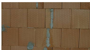
V místě dořezů cihel musí být spáry zcela vyplněny maltou.
