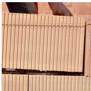
Broušené cihly 249 mm, optimální převazba ½ délky cihly a minimální 100 mm.
