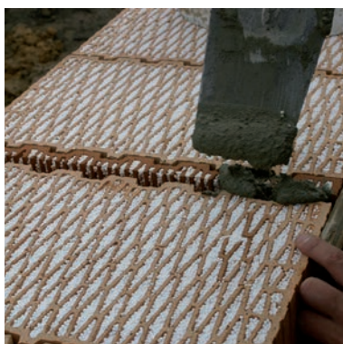
Mezeru mezi cihlami, je nutné vyplnit maltou nebo dořezem cihly a promaltováním (v případě zdění na PU pěnu propěněním dvěma pruhy).
