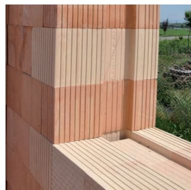
Doplňkové cihly (K, K-1/2, R) a příklad jejich použití v ostění a parapetu.
