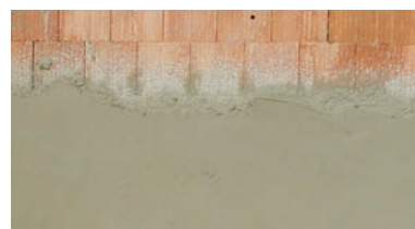
Omítání se obvykle provádí ve dvou nebo třech vrstvách, ručním nebo strojním způsobem.
