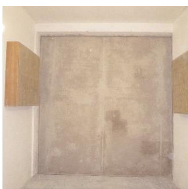
Omítnutá stěna v laboratoři
