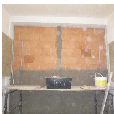
Omítání stěny v laboratoři
