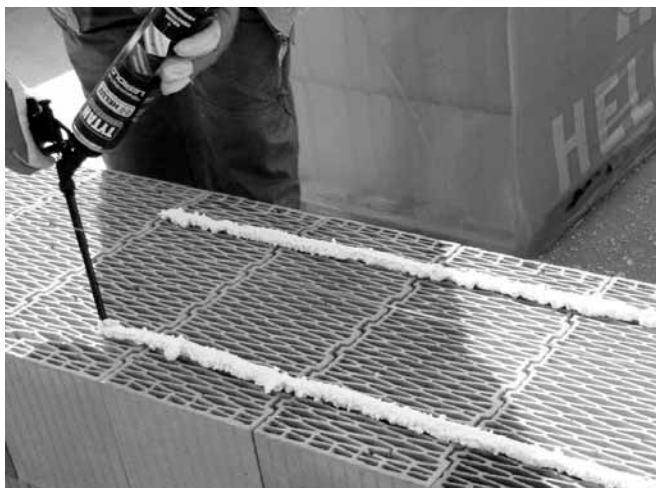
HELUZ pěna - nanášení pěny pomocí aplikační pistole
