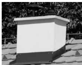
Obr. č. 66: Základní provedení omítnutý komín
