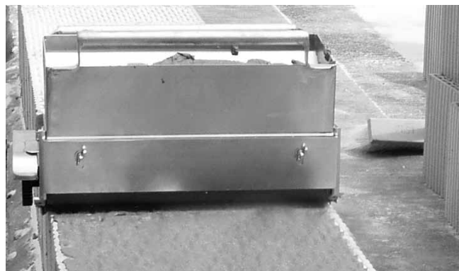
obr. 3 – nanášení malty na vysypané cihly první vrstvy
