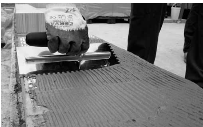
HELUZ celoplošné lepidlo SB C - nanášení zubovým hladítkem na cihly 2in1
