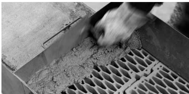
Při vyzdívání je důležitá správná konzistence malty, která nesmí stékat do otvorů ve spodní vrstvě.
