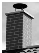
Obr. č. 67: Nadstřešní část obkladový pásek
