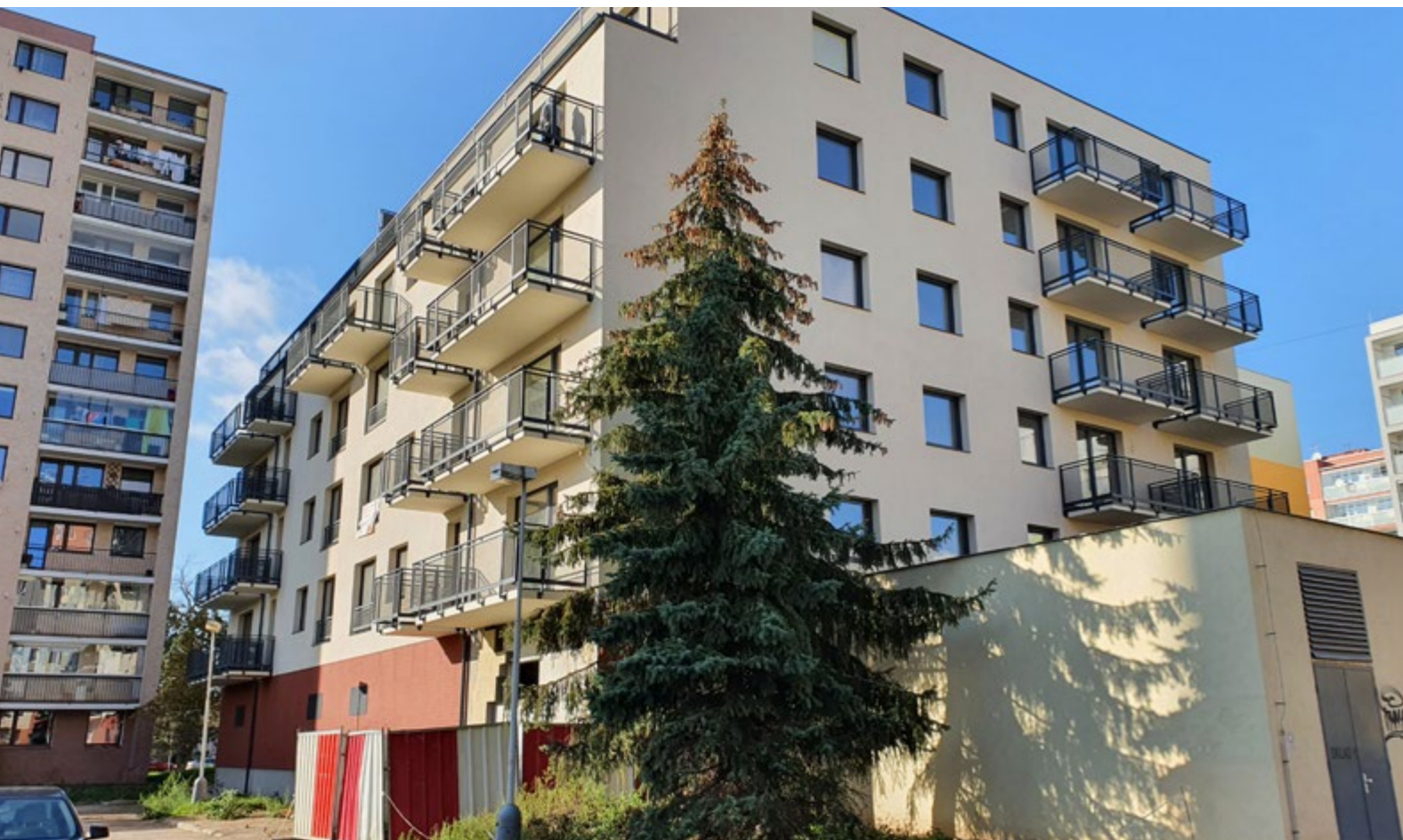
Rezidence Byty u Parku společnosti PRECO GROUP s.r.o.
