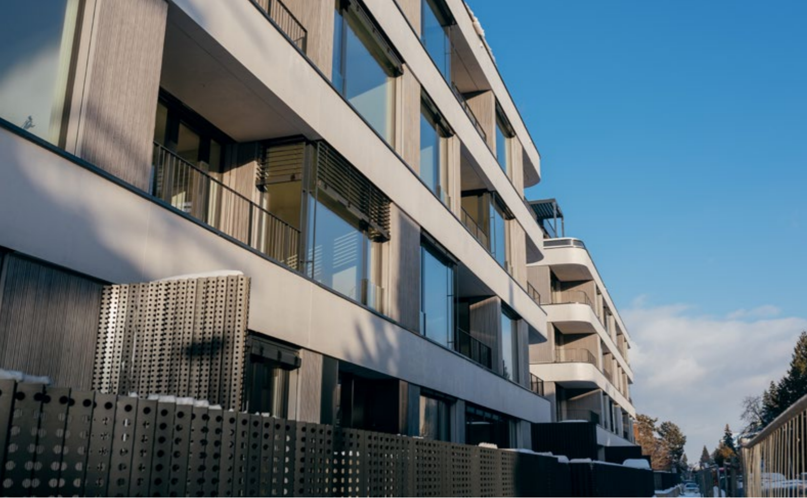
Rezidence MAISON Ořechovka společnosti Penta Real Estate s.r.o.
