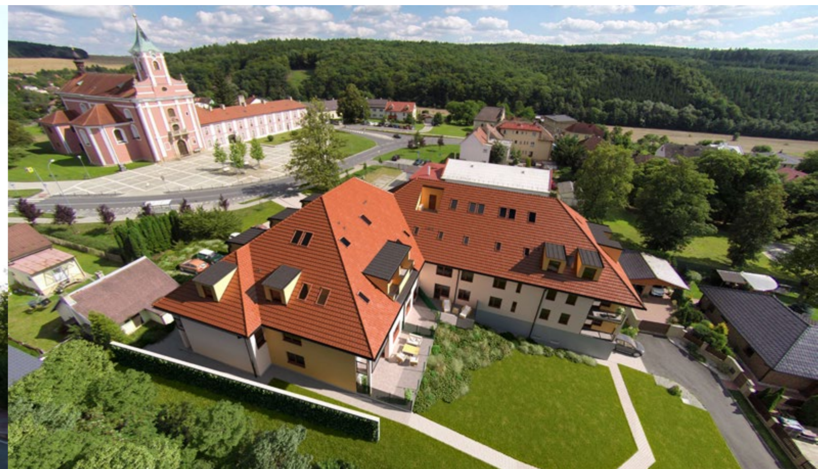
Bytový dům Štípa společnosti SMO a.s.
