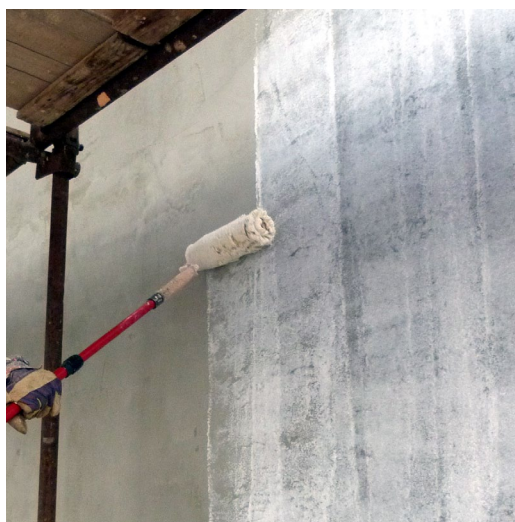
↗ Úprava podkladu penetračním nátěrem
