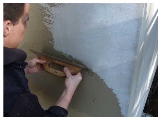
↗ Přestěrkování povrchu Cemix 155 Vyrovnávací sěrkou MULTI
