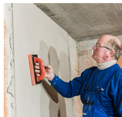
✔ Úprava povrchu filcováním
