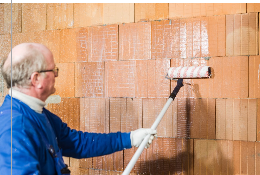
▲ Nanášení Cemix Penetrace základní
