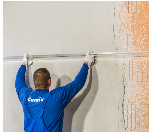
✔ Dorovnání omítky trapézovou latí
