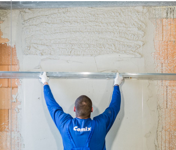
✔ Stahování omítky h-lať
