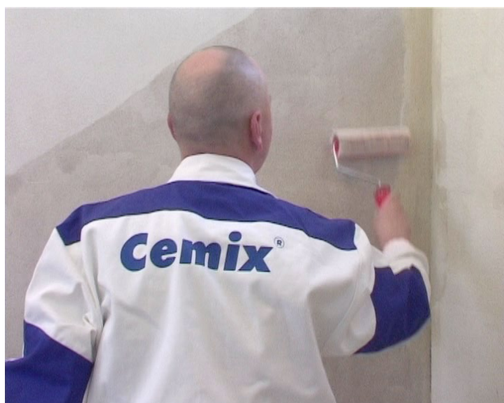
▲ Nanášení můstku Cemix Kontakt BETON
