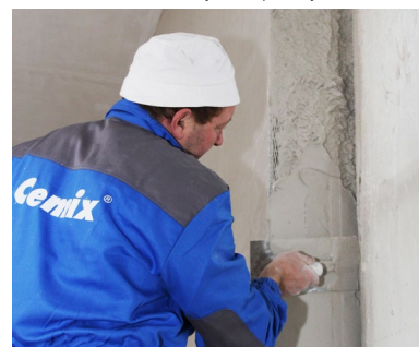
✔ Zkouška zavadnutí omítky
