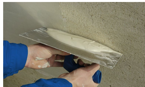
➤ Nanášení sádrové stěrky
