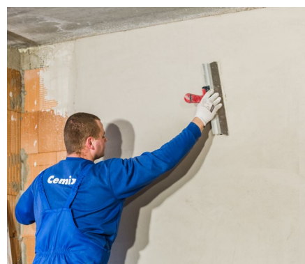
✔ Úprava povrchu gletováním
