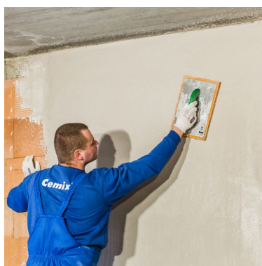
✔ Vytažení šlemu ze zvlhčeného povrchu
