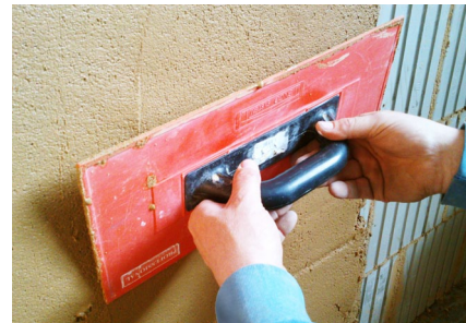
▲ Vyrovnání jemnou omítkou
