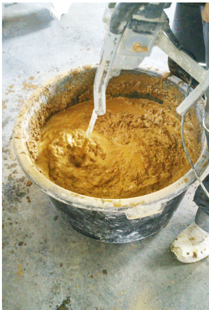
▲ Rozmíchání omítky rychloběžným míchadlem
