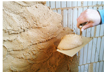
▲ Nahazování jádrové omítky
