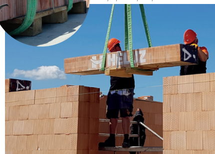
6. Příklad se manipuluje pomocí C závěsu nebo upínacími popruhy prostrčenými pod přepravní paletou, která je dočasnou součástí překladu.
