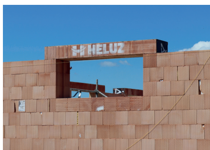
7. Příklad se uloží do maltového lože. Příklad se ukládá se stejnou délkou uložení na každé straně. Nápis „HELUZ“ na čelní ploše překladu směřuje do exteriéru.
