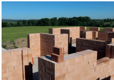
1. Stavba připravená na pokládku překladů.
