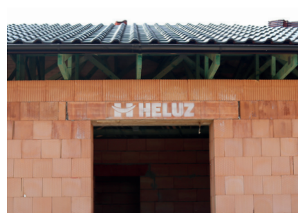
9. Poloha okna je odvislá od volby typu stínící techniky. V případě, že není rozhodnuto o typu stínící techniky, doporučuje se okno montovat do tzv. univerzální polohy.
