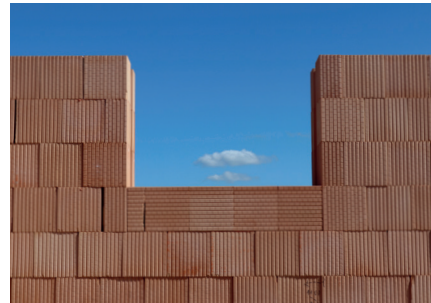
3. Pohled z interiéru před uložením. Zdivo se vyzdí do úrovně uložení překladu.
