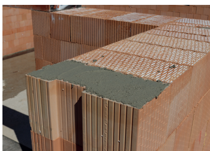
5. Zdivo se v místě uložení překladu namaltuje tenkovrstvou maltou HELUZ SBC v tloušťce 3 mm.
