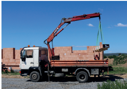
2. Při zabudování překladů se používá zpravidla jeřáb či auto s hydraulickou rukou.
