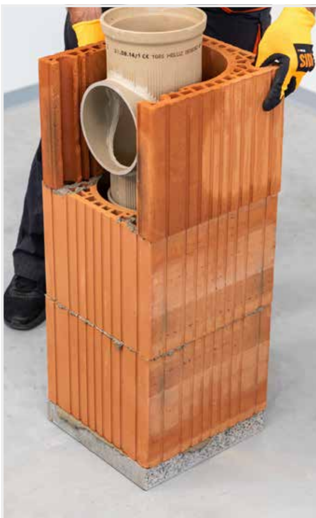
OSAZENÍ VYŘEZANÝCH TVÁRNIC
