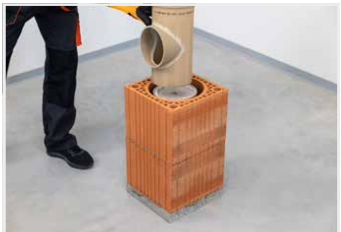
OSAZENÍ VYBÍRACÍHO OTVORU (TVAROVKA BEZ IZOLACE)
