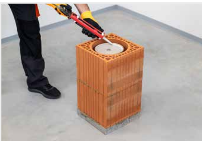
NANESENÍ SPÁROVACÍHO TMELE DO JÍMKY
