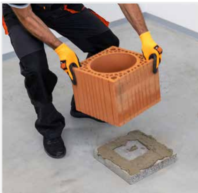
OSAZENÍ PRVNÍ KOMÍNOVÉ TVAROVKY A JEJÍ PRECIZNÍ VYROVNÁNÍ
