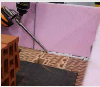
10. Na ložnou plochu cihel se nanese PU pěna.
