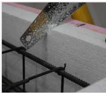
17. Do izolačních desek se v místě uložení velkých spon vyřízne prostup.
