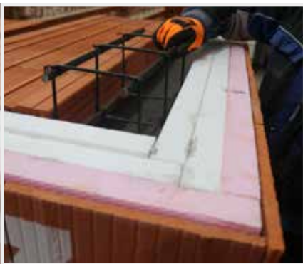
16. Výztuž se vloží do věnce.
