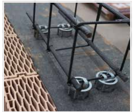
15. Výztuž věnce se opatří plastovými distančníky.
