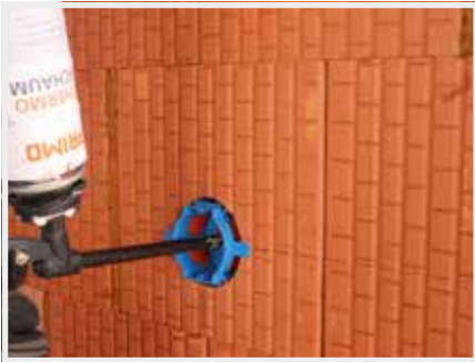
10. Montážní pěna se aplikuje zpětnou klapkou ve středu krabice a bočními výlisky po jejím obvodu
