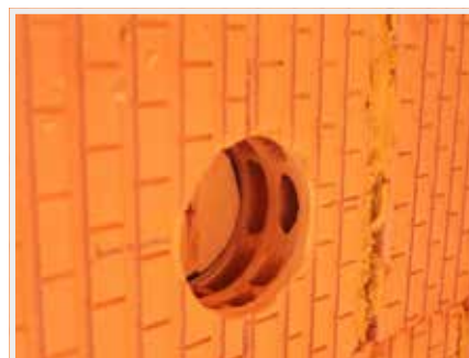
6. Otvor připravený k: 1. osazení krabice nebo 2. vrtací šablony pro vícenásobné rámečky
