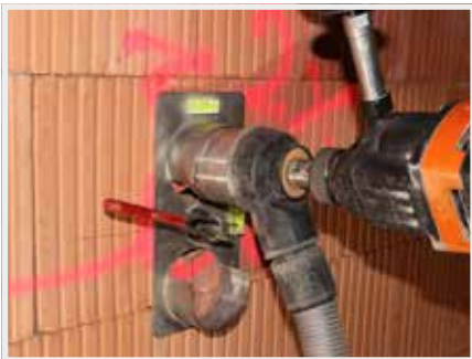
13. Vykroužení otvorů pro násobné rámečky. Šablona má integrované vodováhy.
