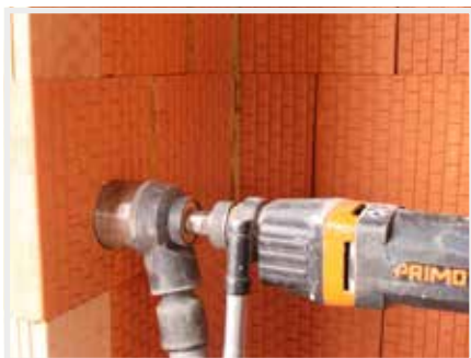
1. Vysokootáčková vrtačka k vykroužení otvoru
