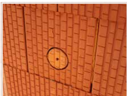
4. Vyvrtaný otvor
