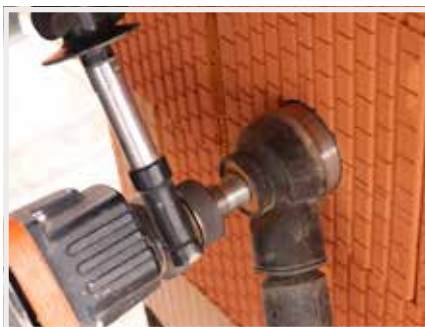
2. Nutno vždy vrtat bez přiklepu. Nedojde k rozpadu cihly
