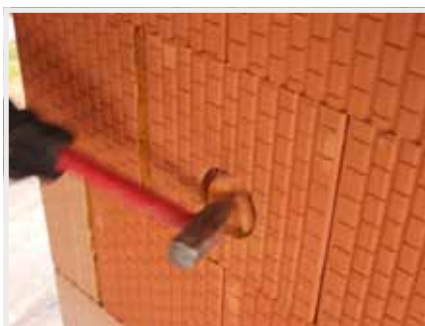
5. Kladívkem opatrně vyvrtanou část cihly odstraníme
