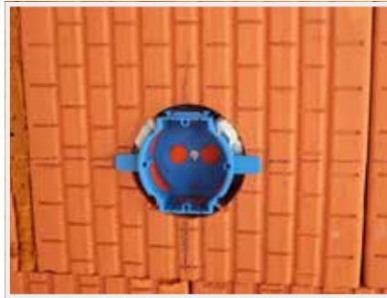
11. Montážní pěnu necháme zaschnout (10 minut lepidlost, 20 minut řezatelnost)
