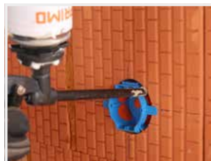
9. Fixace nízkoexpanzní montážní pěnou PRIMO
