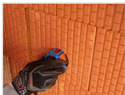
7. Do otvoru vložíme instalační vzduchotěsnou krabici
