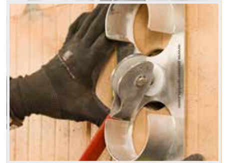
12. Osazení vrtací šablony a její zajištění rychloupínacím mechanismem
