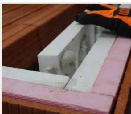
13. Obdobným způsobem se klade i druhá vrstva izolantu.
