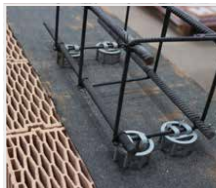
15. Výztuž věnce se opatří plastovými distančníky.
