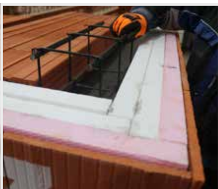
16. Výztuž se vloží do věnce s prostrídáním styčných spár.
