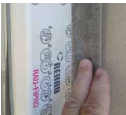
9 Přilepení okenních omítkatelných pásek.
