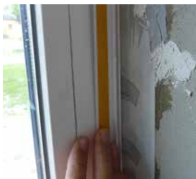
10 Před omítáním se na rám okna nalepí začišťovací – ukončovací lišty.
