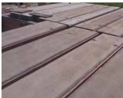
Podepření stropů MIAKO + nadvýšení / pokládka stropních panelů.
