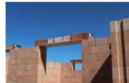
⑨ Pohled na uložený překlad, který je plně únosný. Pro překlady se světlou šířkou stavebního otvoru \geq 2,5 m se provede montážní podepření uprostřed překladu.
