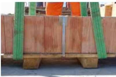
⑦ Detail provléknutí popruhů pod paletou.
