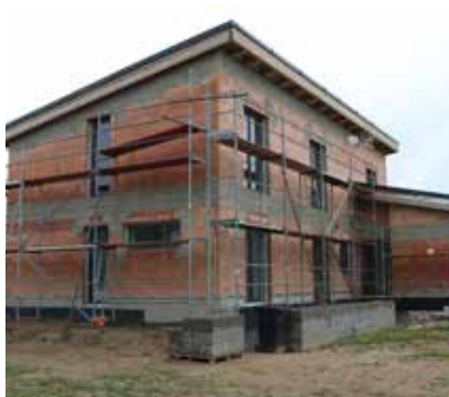
④ Příprava stavby před omítáním. Před omítáním se případně vyspraví zdivo a ošetří se exponovanější místa konstrukčních detailů.
