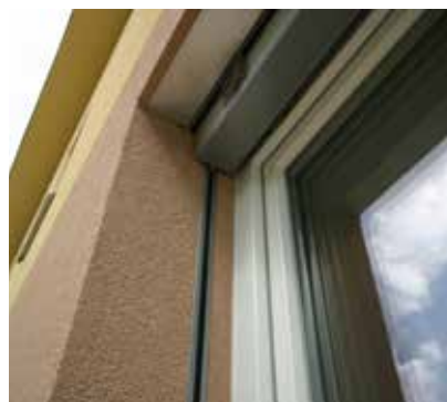
⑨ Pohled na finální provedení stavebního otvoru se žaluzií v roletovém a žaluziovém překladu HELUZ.
