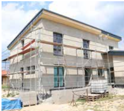
⑤ Provedení jádrové omítky (lehčené nebo tepelněizolační).
