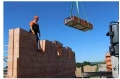
⑥ Překlad se manipuluje pomocí jeřábu a C závěsu za paletu. Překlad lze také manipulovat pomocí popruhů, které se provléknou pod paletou.
