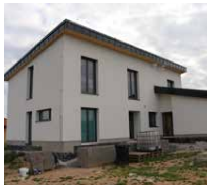
⑥ Dokončené vnější omítky.
