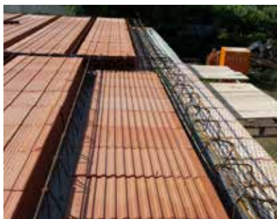
Provedení ztužujících věnců.
