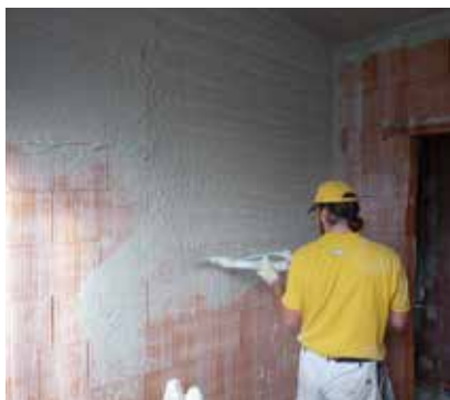
① Strojní nanášení vnitřní omítky.
