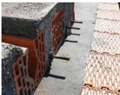
Uložení stropů na asfaltový pás.
