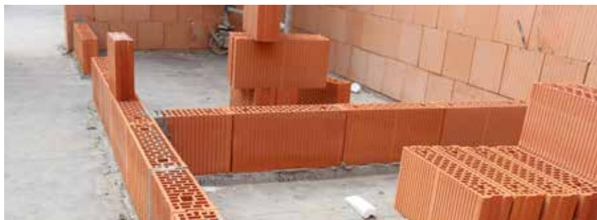
Zdění nenosných stěn (příček).
