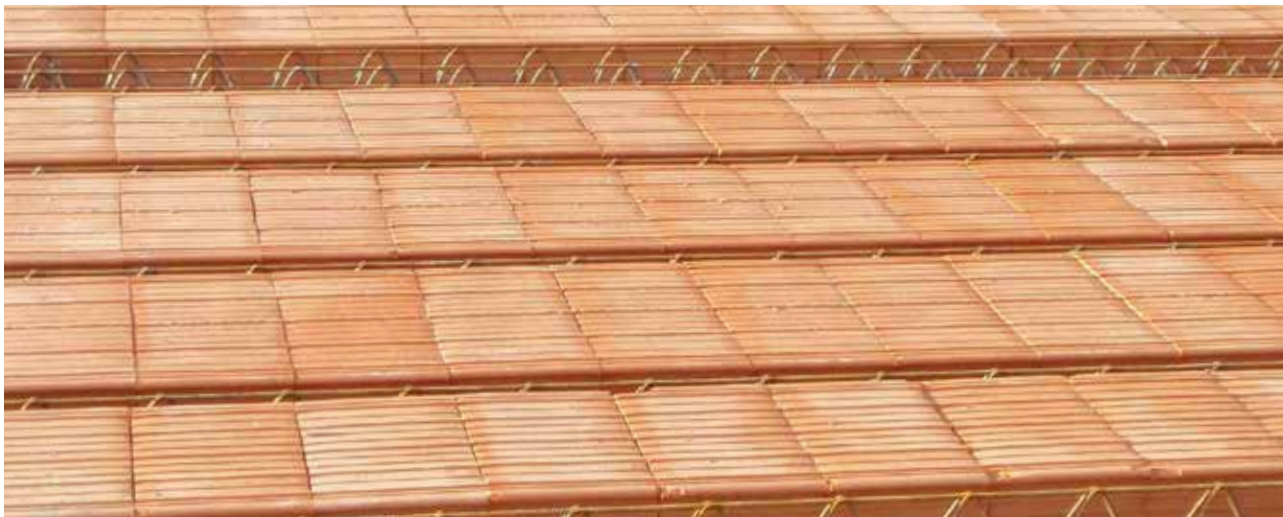
Pohled na uložené nosníky a vložky (před uložením KARI sítí)
