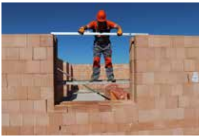
④ Provede se kontrola vodorovnosti zdiva přes stavební otvor s povolenou odchylkou 3 mm. Zkontroluje se světlá šířka otvoru.
