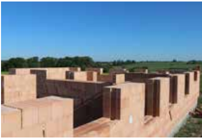
① Stavba připravená na pokládku překladů.
