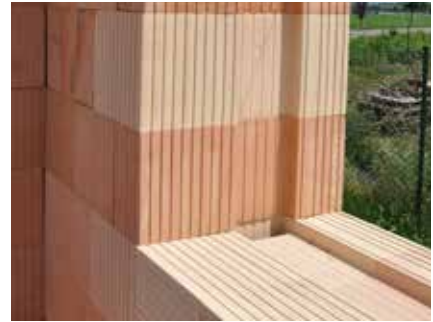
Doplňkové cihly (K, K-1/2, R) a příklad jejich použití v ostění a parapetu.
