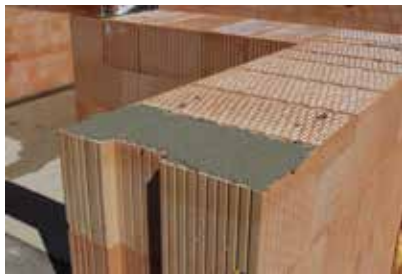
⑤ Zdivo se v místě uložení překladu namaltuje tenkovrstvou maltou HELUZ SBC v tloušťce 3 mm.
