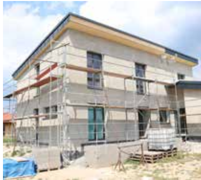
⑤ Provedení jádrové omítky (lehčené nebo tepelněizolační).
