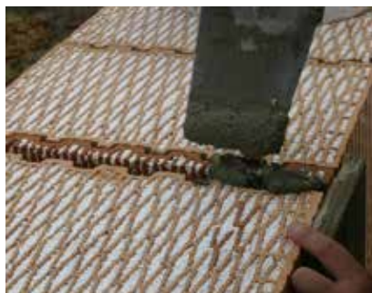
Mezeru mezi cihlami, je nutné vyplnit maltou nebo dořezem cihly a promaltováním (v případě zdění na PU pěnu výjimečně propěněním dvěma housenkami).
