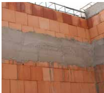
⑧ Kde není homogenní cihelný podklad, tak se zhotovuje zámek z cementového tmelu vyztuženého sklotextilní síťovinou s přesahem min. 100 mm na zdivo.
