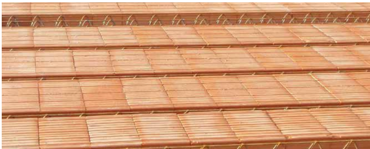
Pohled na uložené nosníky a vložky (před uložení KARI sítí)
