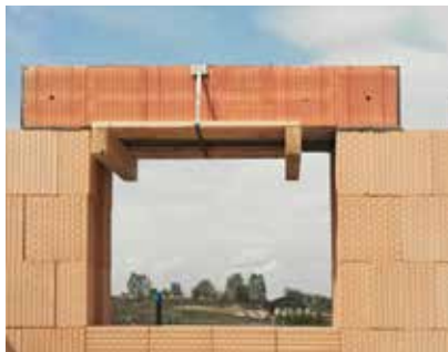
Uložení překladů (PŘEKLAD HELUZ FAMILY 3in1 nosný) do maltového lože.
