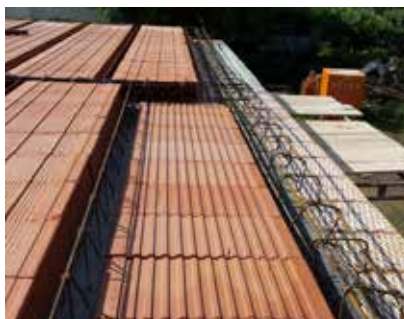
Provedení ztužujících věnců.
