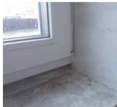
11 Pohled na styk parapetu a ostění po provedení omítek a před osazením finálního vnitřního parapetu.
