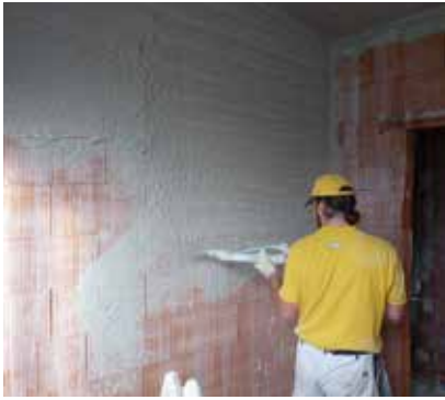
① Strojní nanášení vnitřní omítky.
