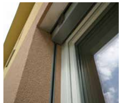
⑨ Pohled na finální provedení stavebního otvoru se žaluzií v roletovém a žaluziovém překladu HELUZ.
