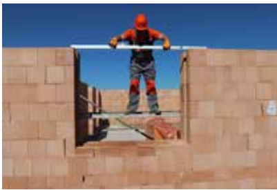
④ Provede se kontrola vodorovnosti zdiva přes stavební otvor s povolenou odchylkou 3 mm. Zkontroluje se světlá šířka otvoru.
