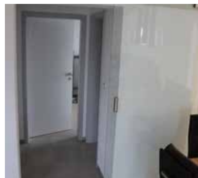
2 Pohled na finální provedení stavebních otvorů – vnitřní dveře.
