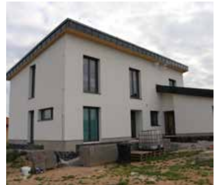
⑥ Dokončené vnější omítky.
