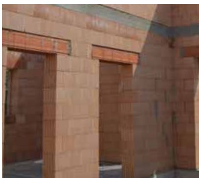
1 Ostění stavebních otvorů ve vnitřním zdivu se zakončuje drážkami, popř. pery cihel, nikoliv řezanou stranou cihel.
