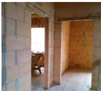
1 Ostění stavebních otvorů ve vnitřním zdivu se zakončuje drážkami, popř. pery cihel, nikoliv řezanou stranou cihel.
