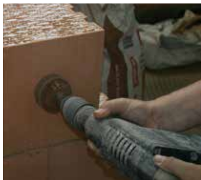
Pro vrtání otvorů elektroinstalačních krabic se doporučuje použití jádrového vrtáku.
