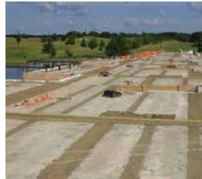
③ K betonáži styčných spár mezi panely se použije beton s maximální velikostí zrna 8 mm pevnostní třídy min. C16/20 – XC1 měkké konzistence S3 dle ČSN EN 206+A1.
