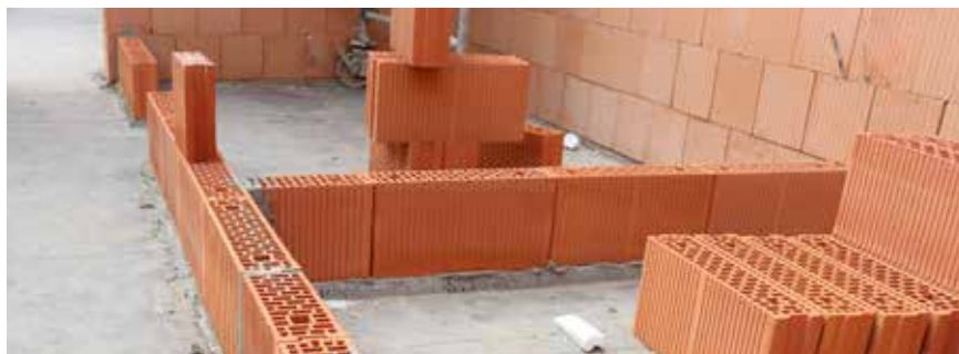
Zdění nenosných stěn (příček).
