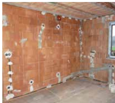
Pohled na zabudované elektroinstalační krabice a rozvedené kabely. Drážky pro rozvody vody a kanalizace musí být co nejmenší.
