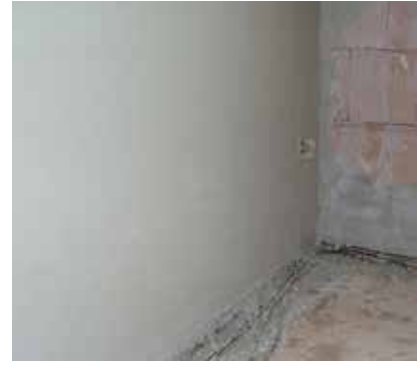
③ Vnitřní omítky se provádí od hrubé podlahy po korunu stěny. Důležité pro zajištění vzduchotěsné obálky stavby.
