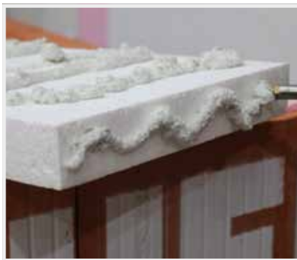
11. Stejně se nanese na styčné plochy desky izolantu.
