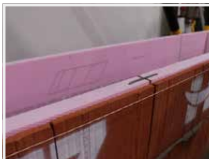
14. Při zdění se doporučuje postupovat postupným (střídavým) kladením věnčovek při vnějším a vnitřním líci zdíva.
