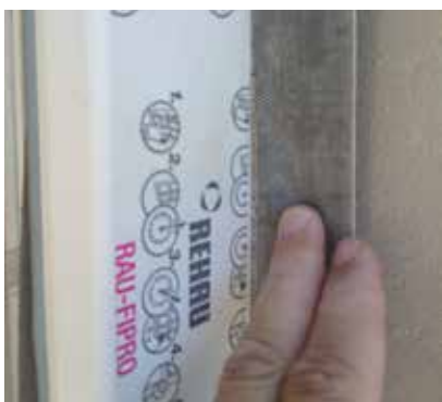
⑨ Přilepení okenních omítkatelných pásek.
