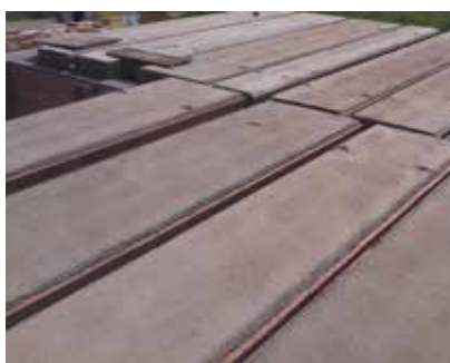
Podepření stropů MIAKO + nadvýšení / pokládka stropních panelů.
