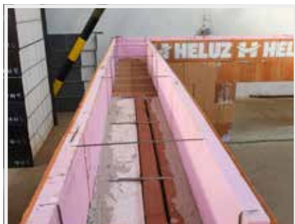
20. HELUZ pěna se nechá vyzrát po dobu min. 24 hodin.
