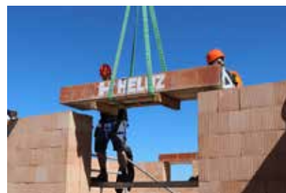
⑧ Překlady se ukládají vždy symetricky s délkou uložení 250 mm s ohledem na snadnost vyndávání segmentů tepelné izolace při montáži stínící techniky. Po usazení překladu se odštírhne vázací páska palety a paleta se odstraní. Strana s logem HELUZ směřuje ven, část s šedým EPS dovnitř.
