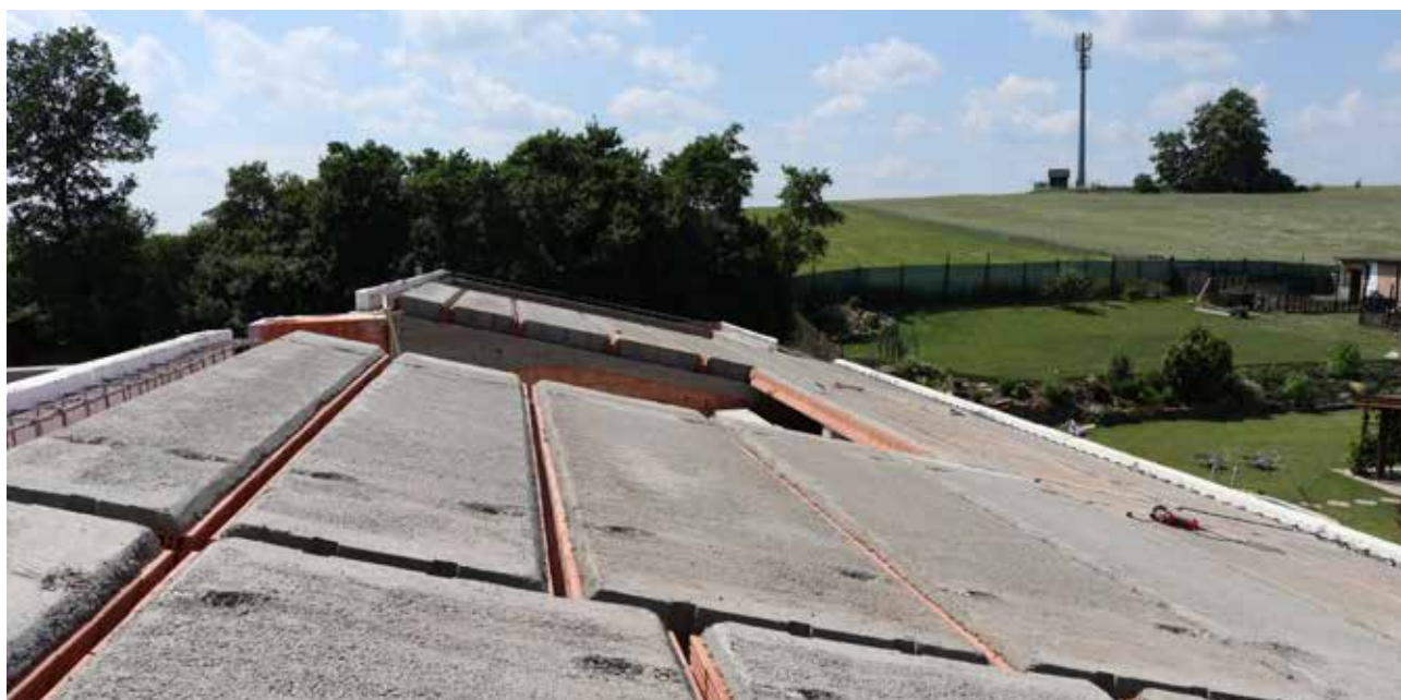
③ K betonáži styčných spár mezi panely se použije beton s maximální velikostí zrna 8 mm pevnostní třídy min. C16/20 – XC1 měkké konzistence S3 dle ČSN EN 206+A1.
