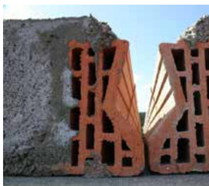
① Detail styčné spáry.
