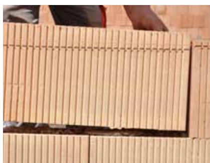
Broušené cihly výšky 249 mm, optimální převazba je ½ délky cihly a minimální 100 mm.
