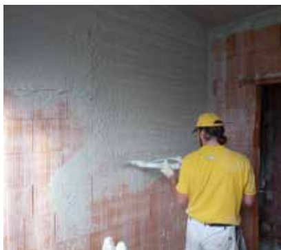
① Strojní nanášení vnitřní omítky.
