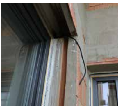
⑫ V případě použití roletových překladů je možné vyříznout v doplňkových cihlách drážku pro vodicí lišty stínící techniky.
