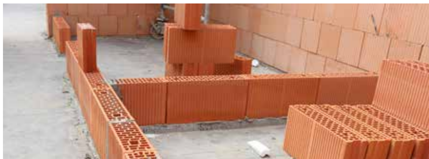
Zdění nenosných stěn (příček).
