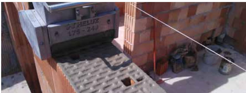
Zdění vnitřních nosných stěn.
