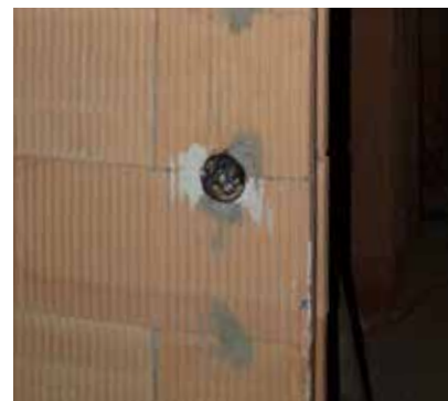
Pro rozvody kabelů např. v příčkách je výhodné použít díry v cihlách. Tím dochází k omezení množství prováděných drážek.
