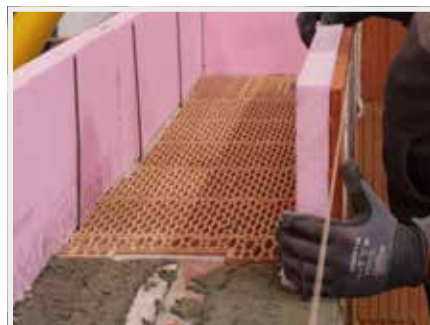
19. Pokračuje se ve zdění věnčovek HELUZ RAPID.
