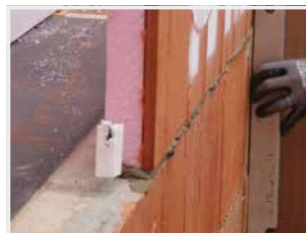
15. V místě překladů se před uložením na spodní povrch věnčovky natluče malá spona. Je vhodné použít chráničku na hrot např. vytvořenou z polystyrenu.
