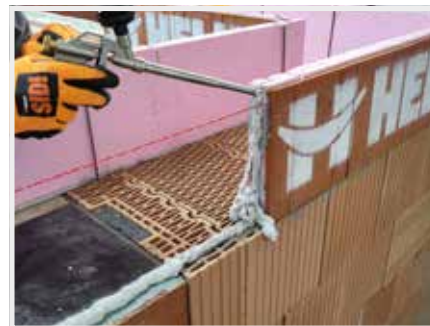
12. Při zdění dalších věnčovek se HELUZ pěna nanáší i na styčné spáry věnčovek.
