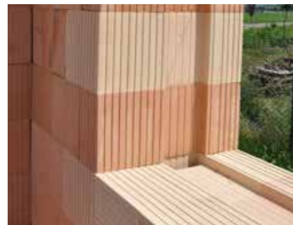
Doplňkové cihly (K, K-1/2, R) a příklad jejich použití v ostění a parapetu.
