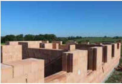
① Stavba připravená na pokládku překladů.
