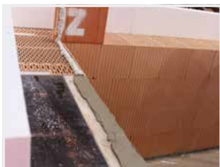
16. Nad překlady HELUZ FAMILY 3IN1 se věnčovky kladou do flexibilního lepidla.
