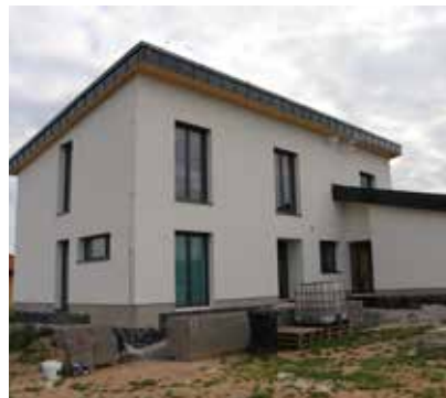
⑥ Dokončené vnější omítky.
