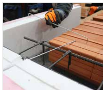
18. Před betonáží se velké spony zatlučou jedním koncem do věncovky RAPID a druhým koncem do vložky HELUZ MIAKO.
