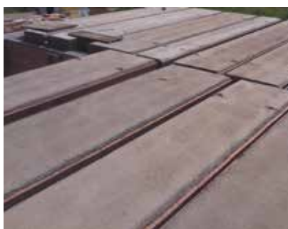
Podepření stropů MIAKO + nadvýšení / pokládka stropních panelů.
