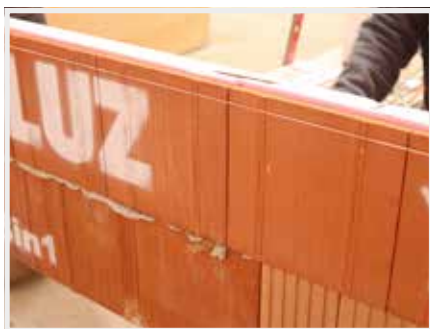
13. Natáhne se zednická šňůra. Při zdění se kontroluje pozice věnčovek vodováhou.
