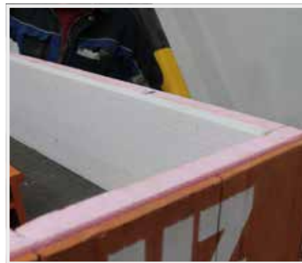
12. Deska izolantu se vloží do věnce a přilepí k věncovce RAPID. Obdobným způsobem se vloží všechny díly první vrstvy izolantu.
