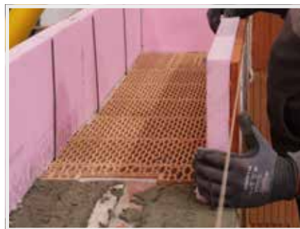
19. Pokračuje se ve zdění věnčovek HELUZ RAPID.
