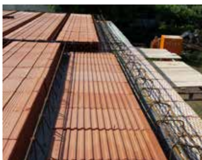
Provedení ztužujících věnců.
