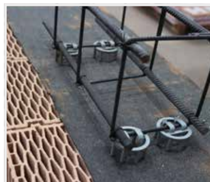
15. Výztuž věnce se opatří plastovými distančníky.
