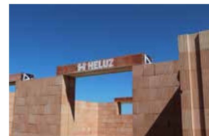
⑨ Pohled na uložení překlad, který je plně únosný. Pro překlady se světlou šířkou stavebního otvoru \geq 2,5 m se provede montážní podepření uprostřed překladu.
