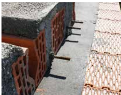
Uložení stropů na asfaltový pás.
