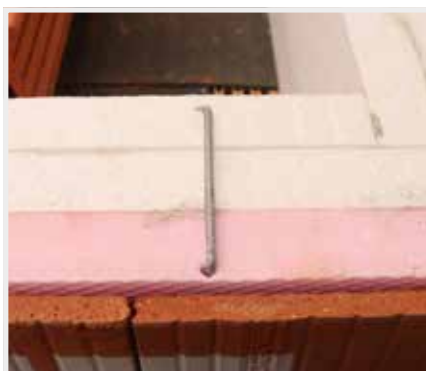
14. Pro stabilizaci izolačních desek lze vhodně využít malé spony.
