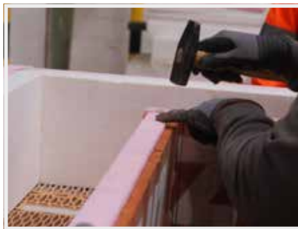
11. Vnitřní roh se zhotoví obdobným způsobem.
