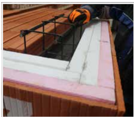
16. Výztuž se vloží do věnce s prostřídáním styčných spár.
