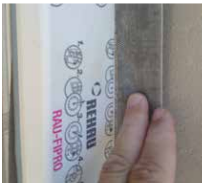
9 Přilepení okenních omítkatelných pásek.
