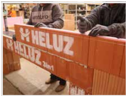
10. Je vhodné po založení rohů na každou stranu stěny připevnit další dvě věnčovky.
