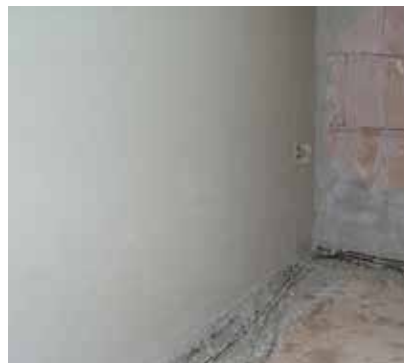
③ Vnitřní omítky se provádí od hrubé podlahy po korunu stěny. Důležité pro zajištění vzduchotěsné obálky stavby.
