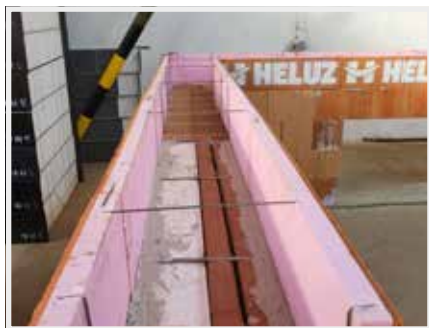
20. HELUZ pěna se nechá vyzrát po dobu min. 24 hodin.
