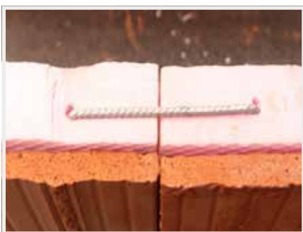
17. Po uložení věnčovky se v místě překladů natluče malá spona i na horní straně věnčovek přes styčnou spáru.
