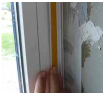
10 Před omítáním se na rám okna nalepí začíšťovací – ukončovací lišty.
