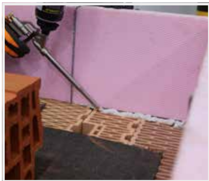
10. Na ložnou plochu cihel se nanese přibližně 3 cm od líce zdiva PU pěna.
