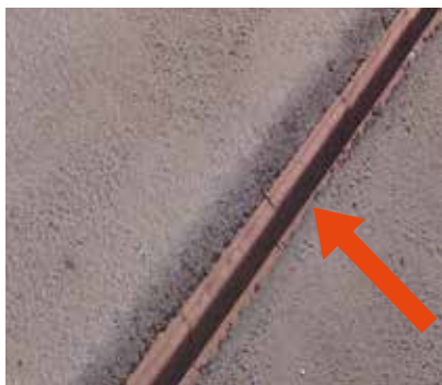
② Styčné spáry mezi stropními panely se musí před betonáží (zejména keramická část) řádně navlhčit.
