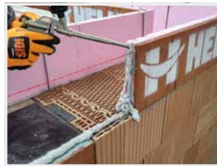
12. Při zdění dalších věnčovek se HELUZ pěna nanáší i na styčné spáry věnčovek.
