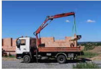
② Při zabudování překladů se používá zpravidla jeřáb. Při manipulaci se používá C závěs nebo textilní popruhy, které se provléknou pod paletou od vnější strany hranolů palety. Jiný typ zavěšení či manipulace mohou vést k poškození překladu.
