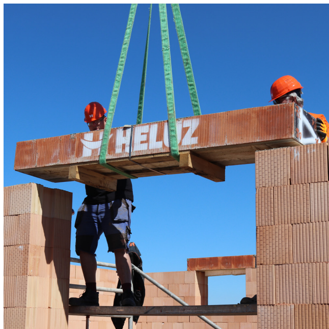
Pohled na uložení překladu z vnitřní části budovy. Paleta se těsně po osazení překladu jednoduše sundá.
