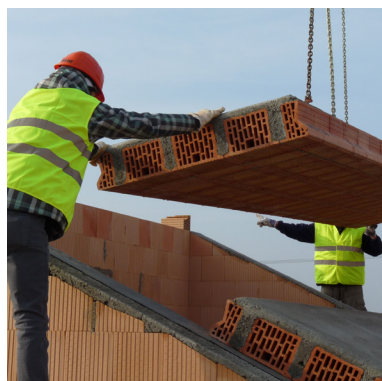
Pokládka panelů HELUZ.
