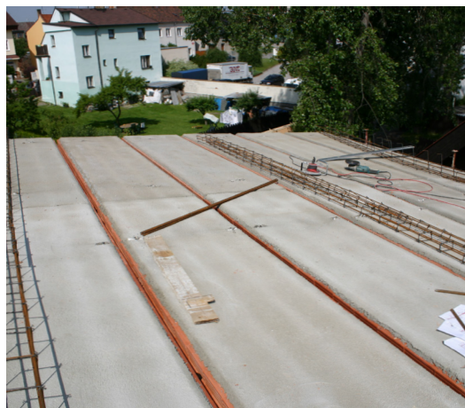
Uložené keramobetonové panely HELUZ
