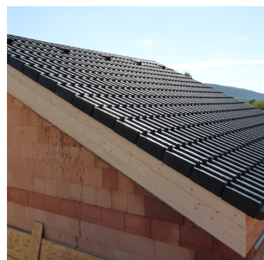
Dokončená střecha se skládanou střešní krytinou.
