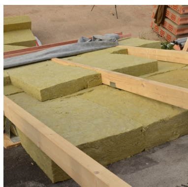
Kladení tepelné izolace ve dvou vrstvách.
