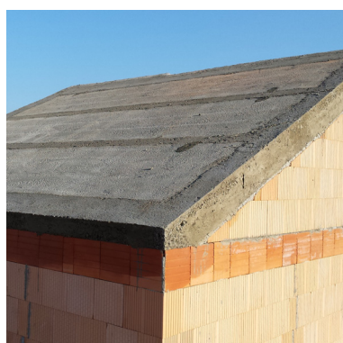
Střešní rovina z panelů HELUZ.
